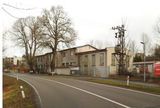
Abb. 20. Werksgebäude im Jahr 2026.
