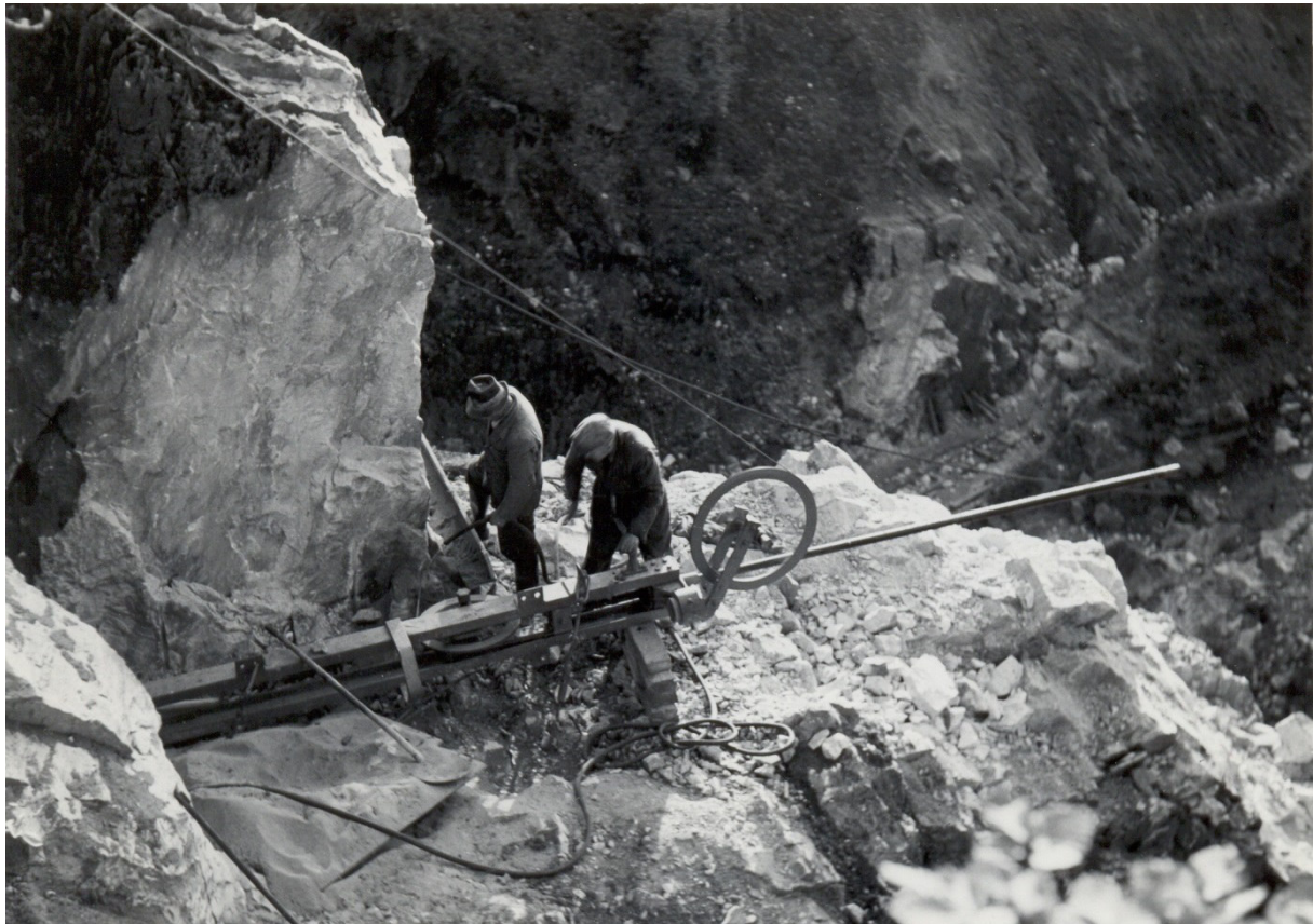
Abb. 13. Seilführung der Helikoidalsäge mit Spanneinrichtung, 1973 (Foto: Hynek Šantl).
