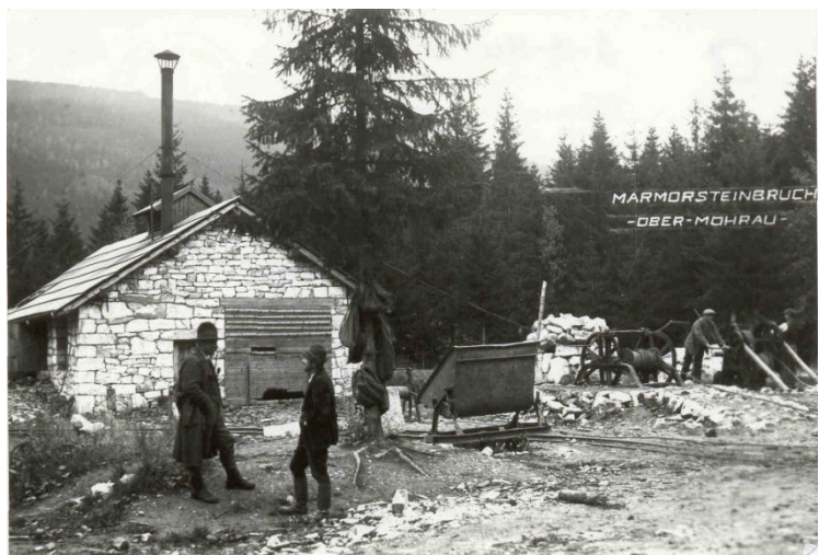
Abb. 12. Betriebsgebäude im Steinbruch (Foto: Josef Walter).
